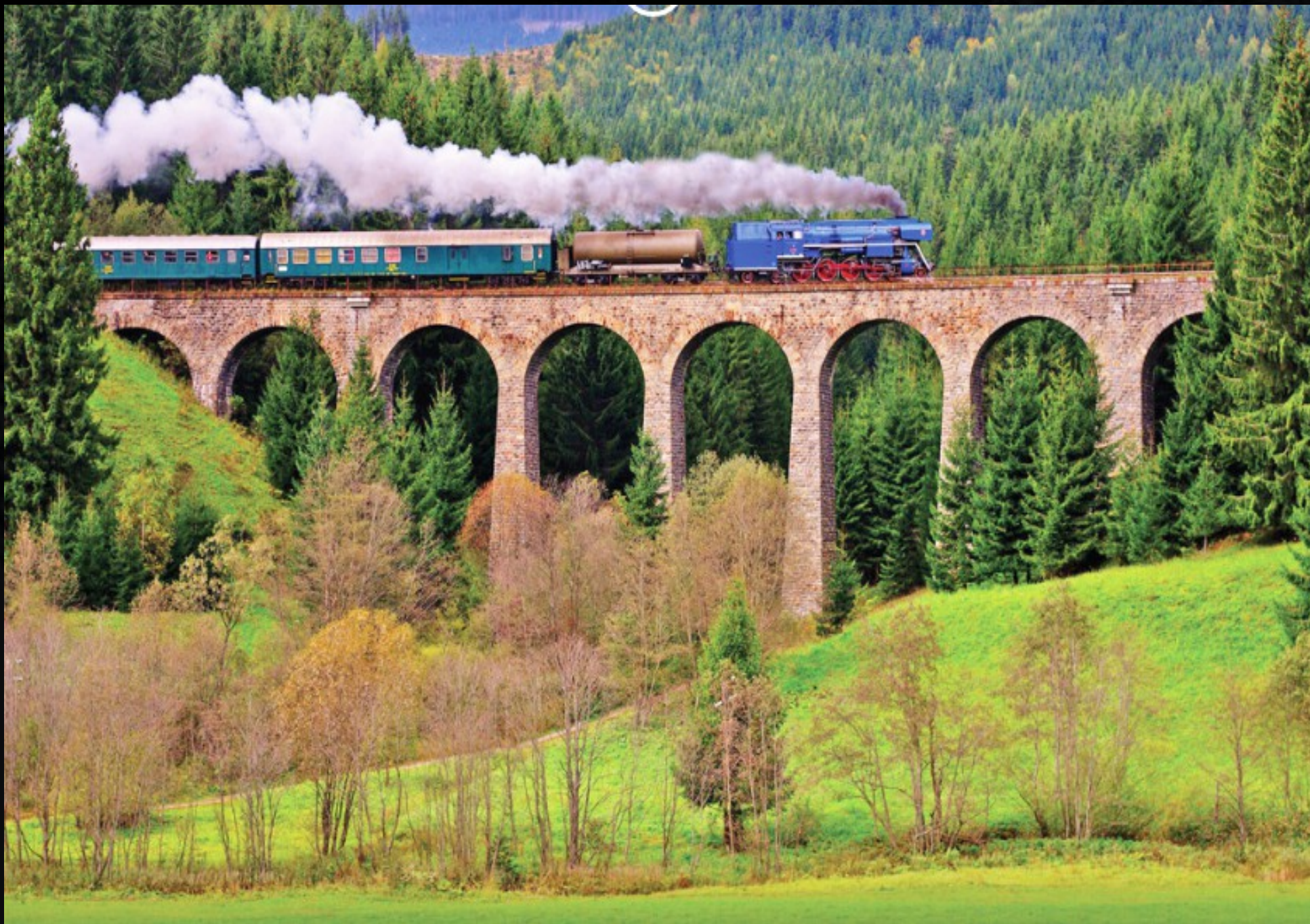
Železničný most, Telgárt
